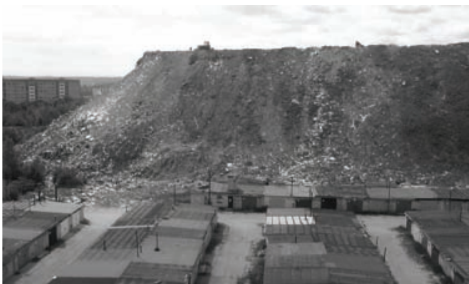
Рис. 1. Фрагмент северного борта насыпного тела полигона
