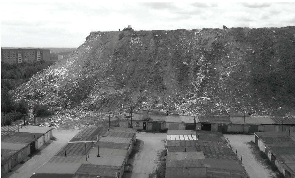
Рис. 1. Фрагмент северного борта насыпного тела полигона
